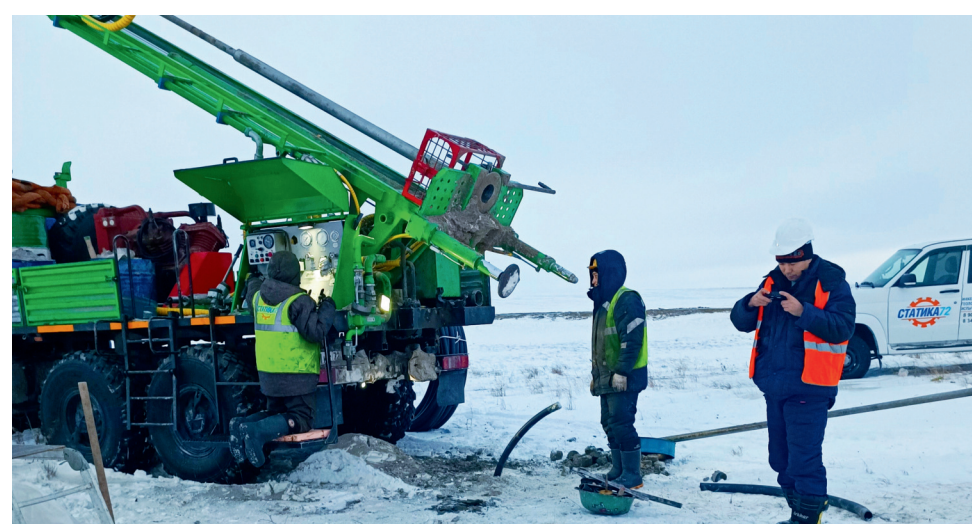
Расширение железнодорожной линии Обская-Карская
